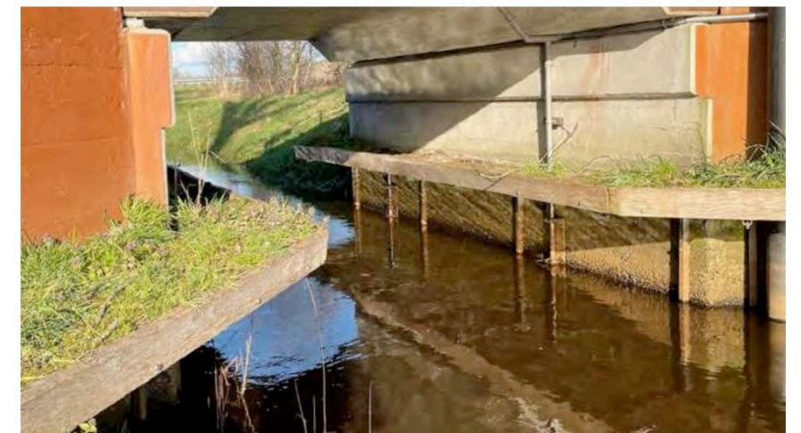
Figuur 19: Voorbeeld van faunapassage onder een brug
